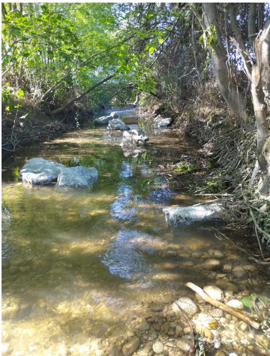
Travaux sur le Rival
